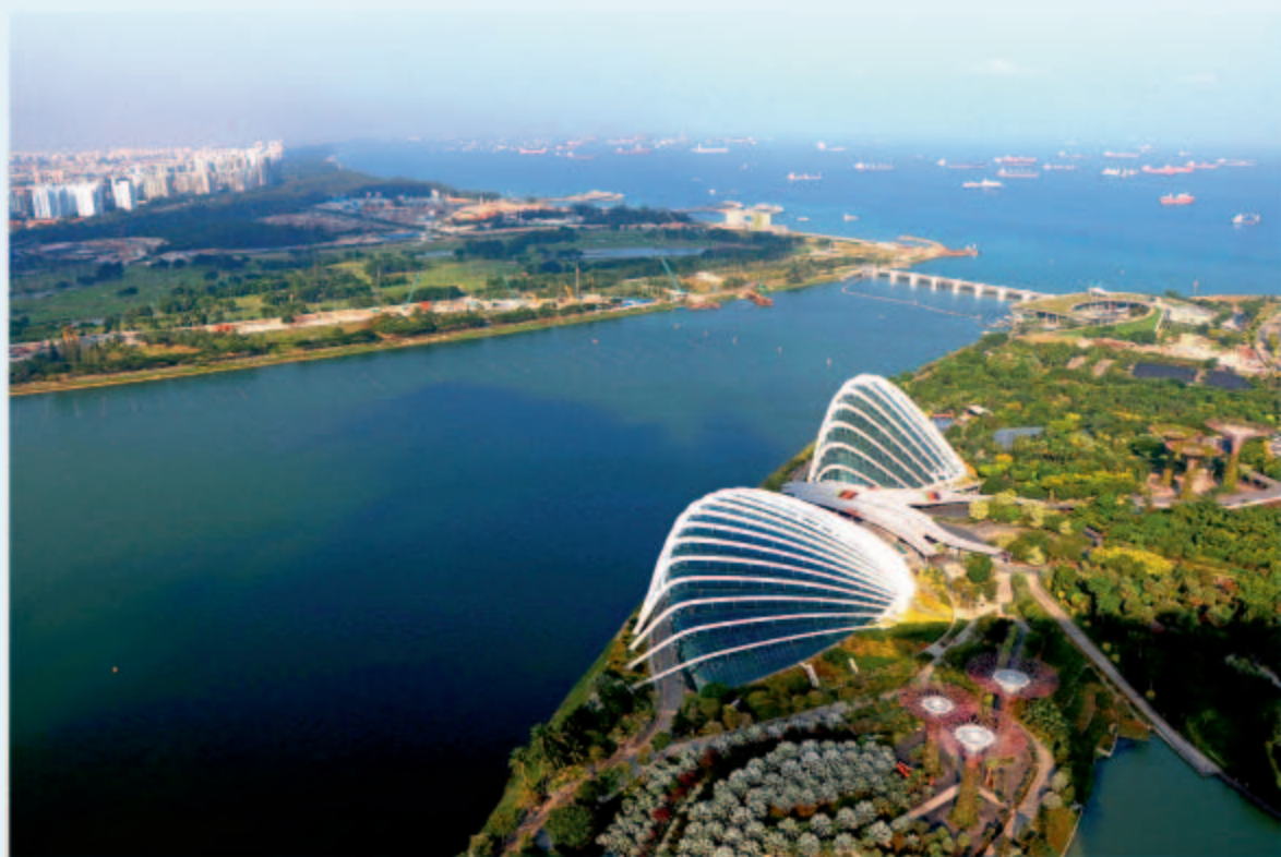
图3.18 新加坡滨海堤坝景观
