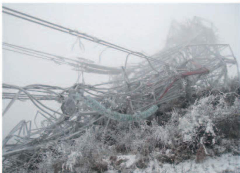
■ 图6.8 寒潮破坏输电线路
